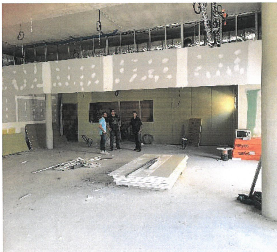
En présence de Monsieur Jacques MARTI , visite de l'intérieur du bâtiment, avant la pose du doublage phonique.
