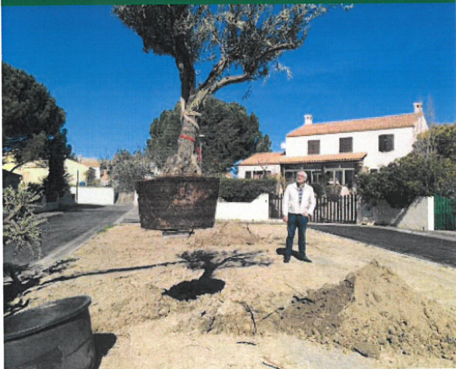
Fin de l'aménagement de la voirie et du terre-plein central du Lotissement Mail de St Alban avec la plantation d'oliviers.
